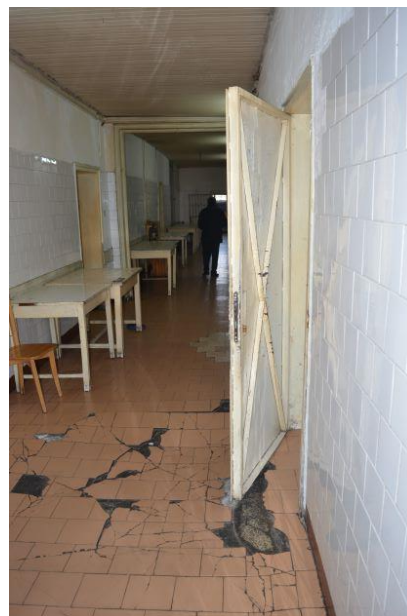
Подовата настилка в тесните коридорите е захабена с пропаднали и изпочупени плочки
