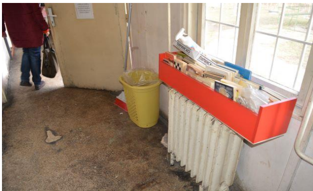
Подовата настилка в тесните коридорите е захабена с пропаднали и изпочупени плочки
