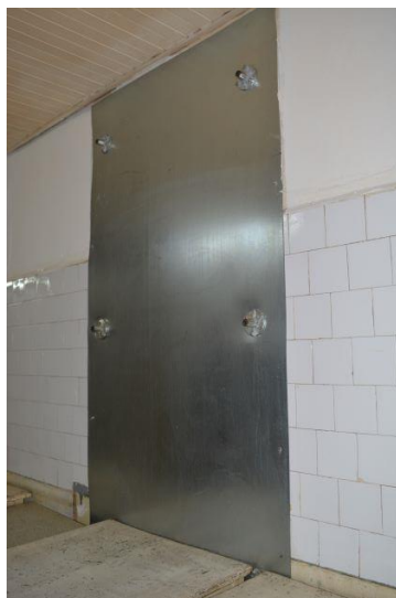
Метални подпори и планки укрепват стените и тавана
